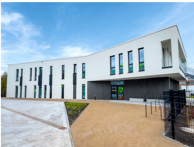
Die Außenansicht der neuen Kita am TÜV NORD Campus in Essen.
